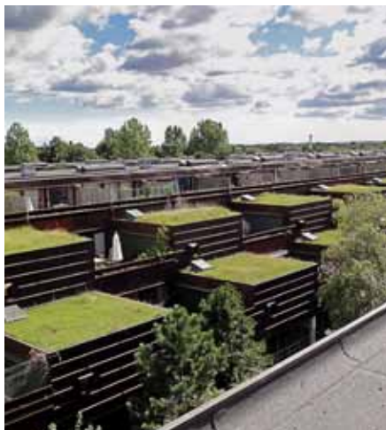
Farum Midtpunkt skærer energiforbruget ned til det halve ved at skifte fra AC- til EC-ventilatorer.
