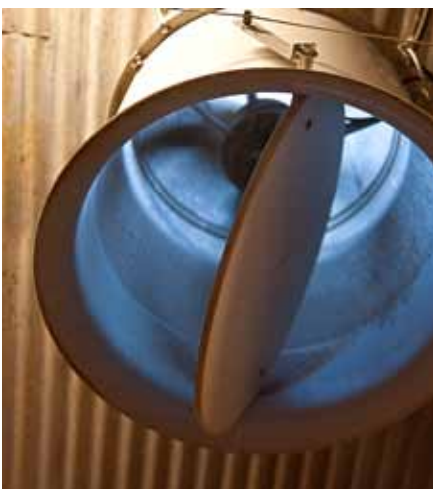
EC staldventilator fra ebmpapst. Passer til alle ventilationsanlæg og giver el-besparelser på 50-70 procent.
